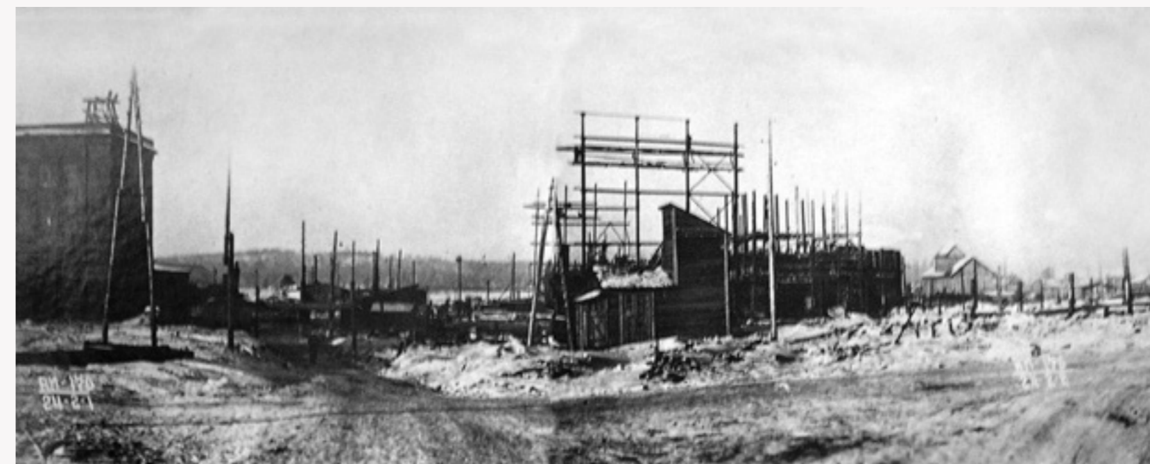
Errichtung des Heizkraftwerkes. Bogoslowlag. Februar, 1943. Archiv des Labors für Historische Informatik.
