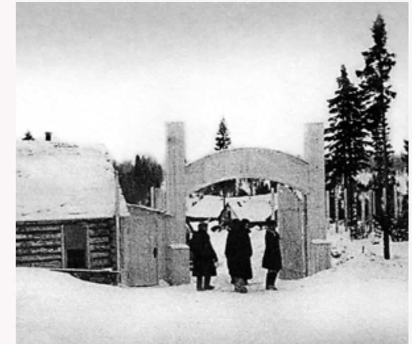
Errichtung der Ponyschewskaja Wasserkraftanlage, 1. Abteilung des Ponyschlag des NKWD, Wache, Rajon Tschusowaja, 1943.
